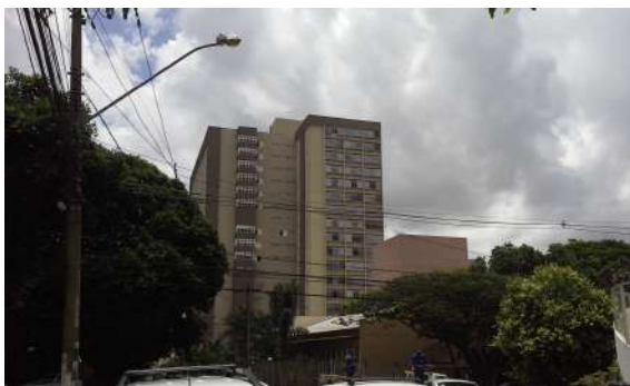
Nova sede do Hospital das Clínicas
